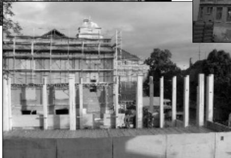
An der Nordwestseite fällt das Gerüst und der neue Putz wird sichtbar.
