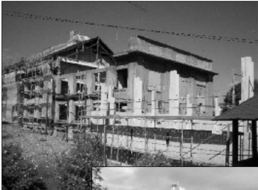
Die Betonstützen für die neue Turnhalle werden gesetzt.
